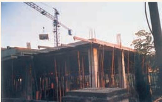
Foto 5. Edificio con el pilar de esquinas insuficientemente armado para resistir acciones sismáticas. Obsérvese que los pilares centrales tienen más armadura, lo que demuestra que la estructura ha sido dimensionada sólo a acciones verticales y estáticas.
