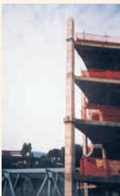
Foto 6. Nudos excesivamente débiles en un edificio de hormigón armado con forjados reticulares. Sus pilares están girados bajo un ángulo de 45º respecto a la dirección según la cual se espera el mayor desplazamiento horizontal durante un terremoto. La conexión pilar-forjado que puede verse es sumamente débil lo que reduce aún más la ductilidad estructural.
