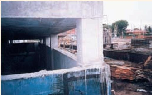
Foto 4. Edificio de hormigón armado con pilares cortos en su base. La mayor rigidez de éstos implica un incremento del esfuerzo cortante que puede producir un fallo frágil de la estructura.
